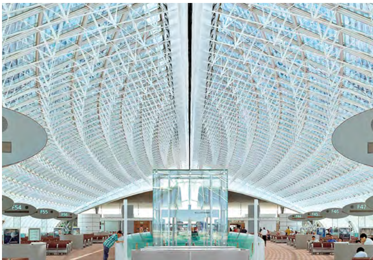
En el aeropuerto Charles de Gaulle, en París, la chapa de acero inoxidable trapezoidal con perforaciones de 68 mm, está instalada en el exterior del vestíbulo de salidas acristaladas, para proteger el interior contra el sol.
