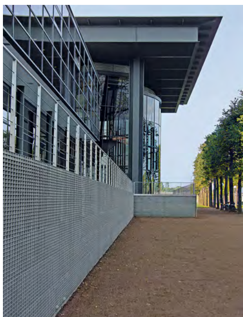
La rejilla de acero inoxidable soldada se usa como protección solar en la Mediathèque, en la ciudad francesa de Sélestat.
