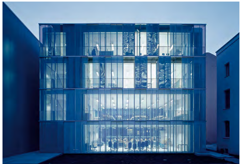
La variedad de funciones en el interior se refleja en la cambiante cara exterior del edificio. Paneles fijos de metal expandido se intercalan con otros deslizantes que los usuarios pueden colocar como deseen.
